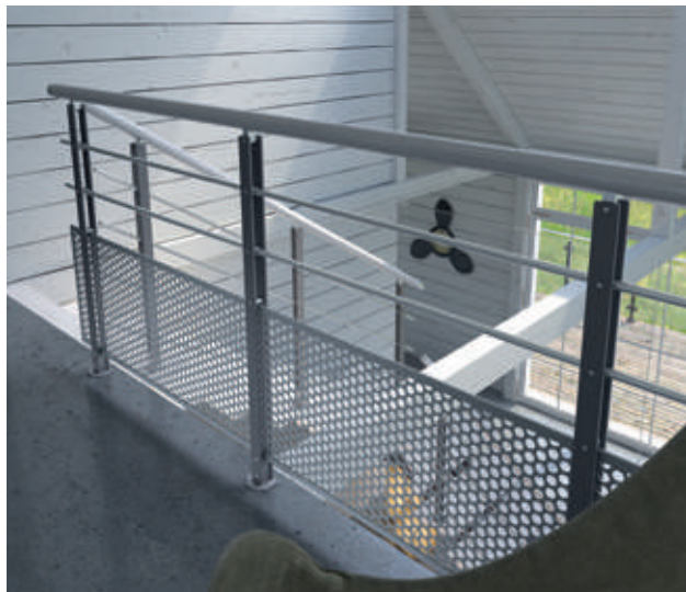
Garde-corps tubes inox et caillebotis à l'étage.
